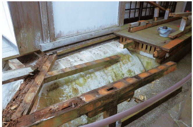
本堂外廊下修繕の様子
